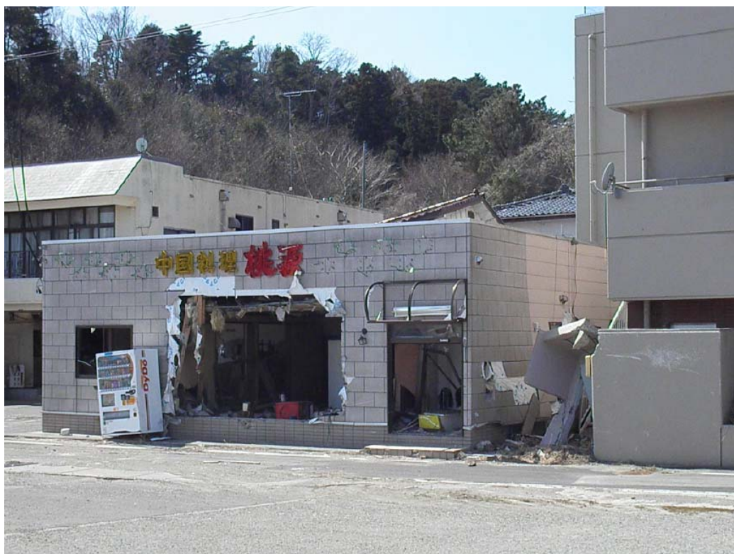
津波で窓ガラスが破られた駅前の中華料理店
